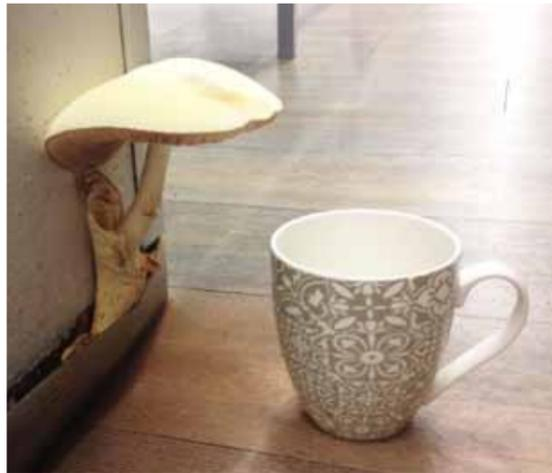
Die Trittschalldämmung im Bodenaufbau gilt als moderner Baustandard. Keime zum Wachstum von Bioaktivität, insbesondere Schimmelpilz, müssen dort nicht hinein, denn diese sind schon seit der Bauzeit drin. Kommt es zum Wasserschaden, beginnt dort das Wachstum und man hat es mit reichlich „Leben unter dem Fußboden“ zu tun. Vorsicht ist geboten.
